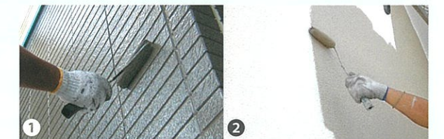
乾式外壁材の再塗装
