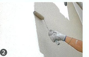
湿式外壁材の再塗装
