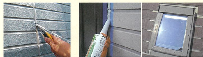
安全基準に従い、足場を組み、劣化したシーリング材は取り除きます。
