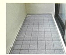
再シーリング。
