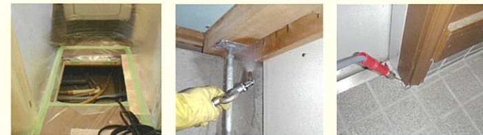
床下点検口から床下に潜り、白蟻の有無を確認します。
